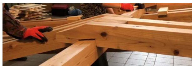
写真-3 主材端部組み方
