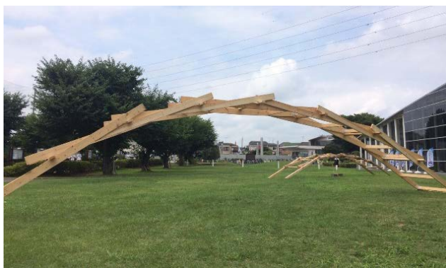
写真-1 組み立てられたサルバティーコ橋(2017.8.2)
