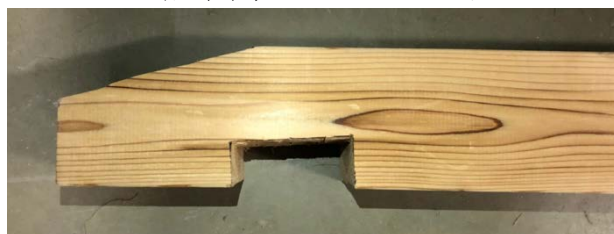
写真-2 主材端部溝
