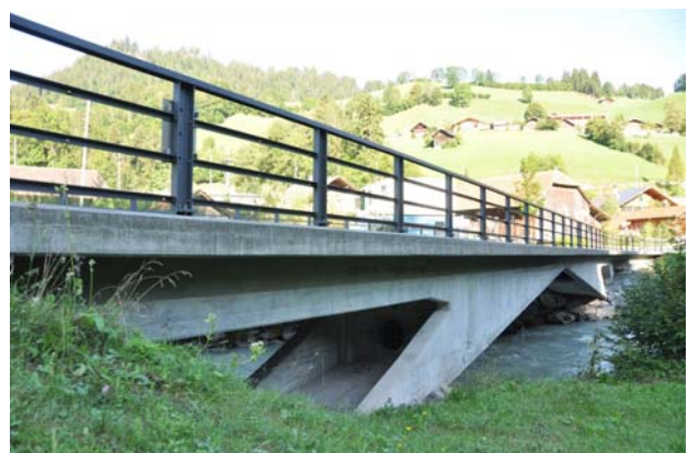
写真-11 Simmebrücke Garstatt (1925)
