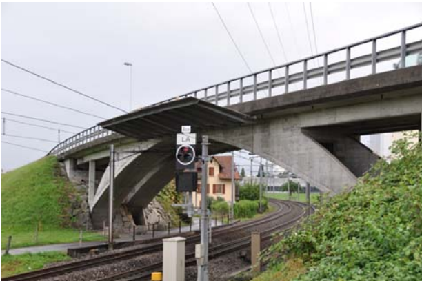
写真-8 Brücke Churerstrasse Altendorf (1940)
