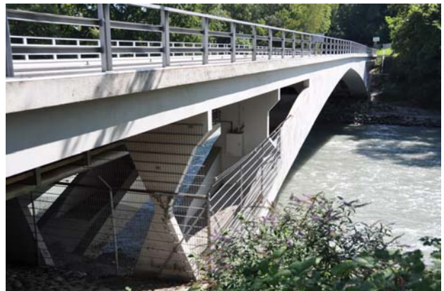
写真-10 Pont de Vessy (1936)
