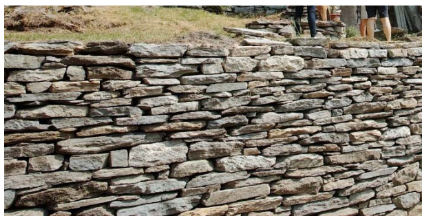
図-2 オッソラの近年修復された石積み擁壁
