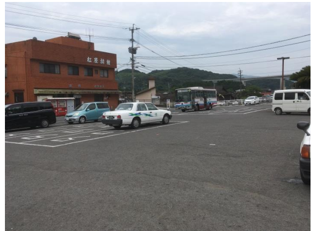
写真-10 杵築駅前広場の現状
