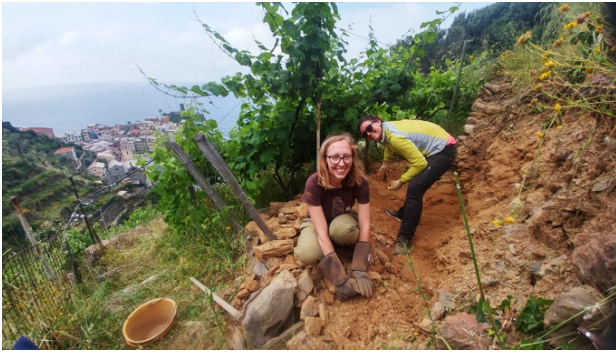
図-5 空石積みの修復の様子 (リグーリア州の農家提供)
