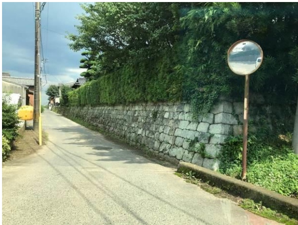
図-2 屋地盛された宅地
