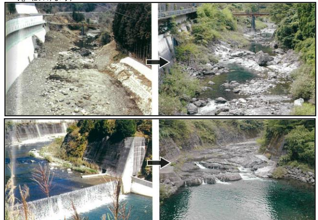
写真2 北川川(左:整備前、右:整備後)(掛水雅彦『川の外科医が行く』(2011)より)
