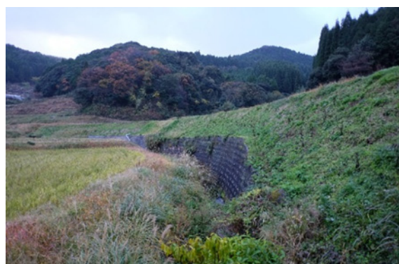
写真-4 伊万里市「木場水路」
