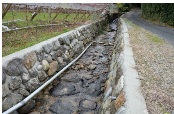
写真-2 久留米市「八幡川」
