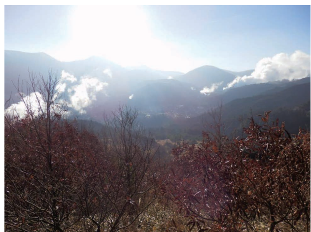
写真-2 九重連山の手前に写る八丁原地熱発電所 6)
