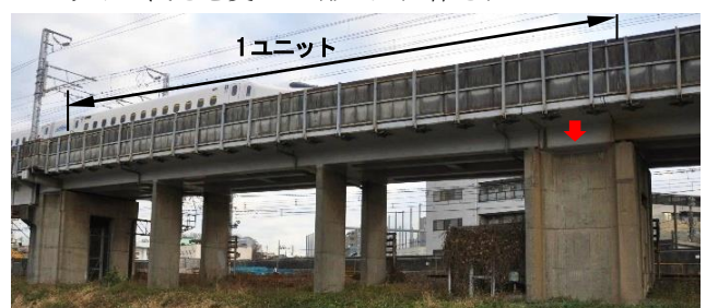
写真-14 目黒川地区高架橋(軟弱地盤のためユニットを短くした)
