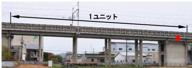
写真-15 向日町地区高架橋(躯体高さ 15m)
