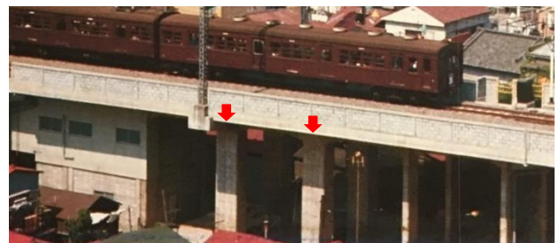
写真-12 根岸線吉浜高架橋 10) (矢印が太い橋脚)
