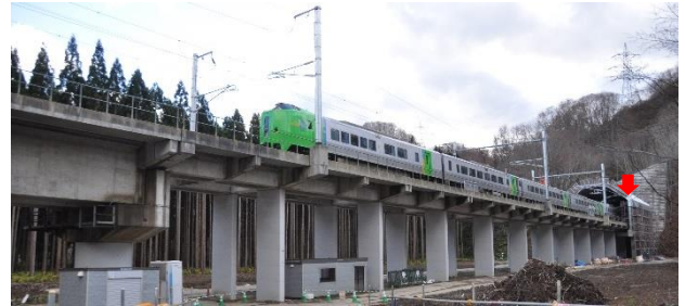
写真-19 津軽海峡線重内高架橋(トンネル坑口が変位拘束部材)
