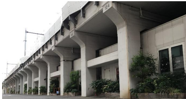
写真-3 上野-神田間 スラブ式高架橋
