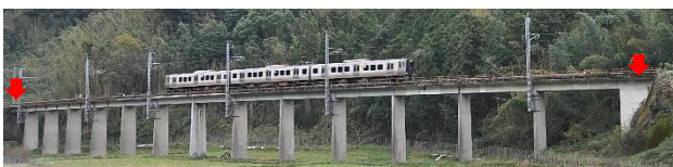
写真-18 篠栗線黒石高架橋
