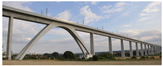
写真-23 ウンシュトルト高架橋 (躯体高さ 50m)
