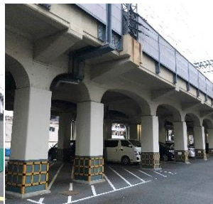
写真-5 近鉄鶴橋高架橋
