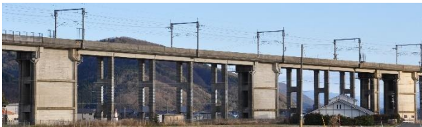
写真-16 湖西線塩津高架橋(躯体高さ 25m)
