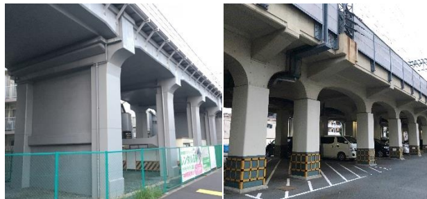
写真-4 東急大井町高架橋
