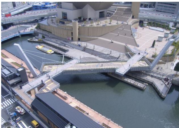
図 - 24 浮庭橋の全景（提供：古市和行）
