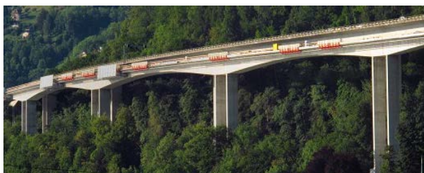
写真-1 シヨン高架橋 4)
