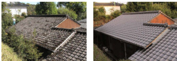
図-3 シラス瓦による改修事例
