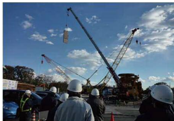
図-8 景観アドバイザーとの現場確認
