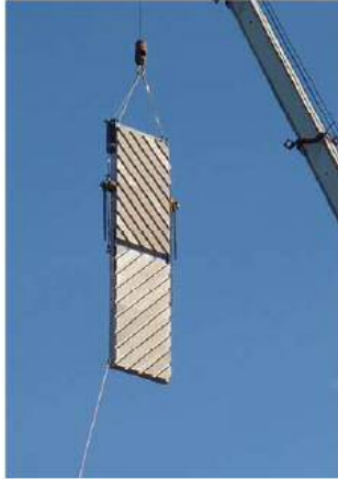
図-26 モックアップによる確認
