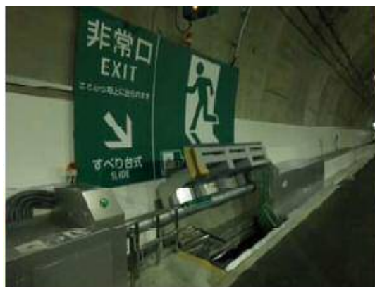
図-5 非常口跳ね上げ扉
