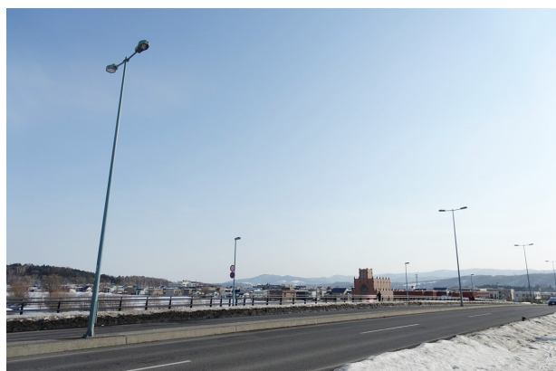
写真-6 旭川市北彩都地区の照明柱(氷点橋) 10BG5/2
