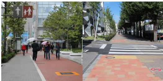
図-3 環状2号線の歩道。左は本道の新橋付近 2016年1月撮影、右は飯田橋付近 2015年11月使用ブロックも貼り方も異なる
