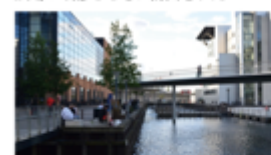
(3) 2014 年 Cykelslangen 港の上を走る230mの自転車道。地上は歩行者が滞留する空間であったため、水上に橋を架ける計画が生まれた。
