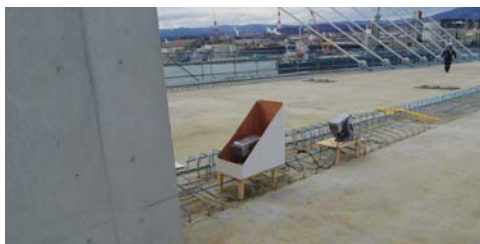
写真-1 歩道側投光器の設置状況
