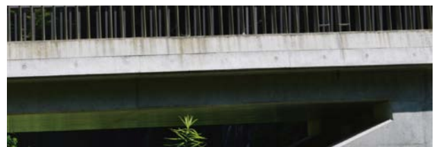
写真-8 ④完成から約3年経過した下流側南の表面性状
