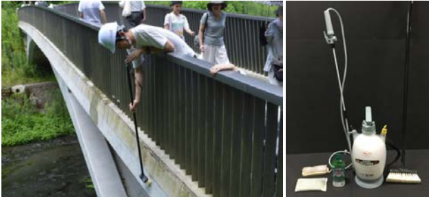
写真-9 滝見橋の表面洗浄の状況 写真-10 洗浄の道具
