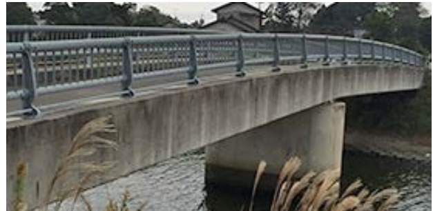
写真-3 沿岸部における完成から11年経過した高聖橋（千葉県長生郡）
