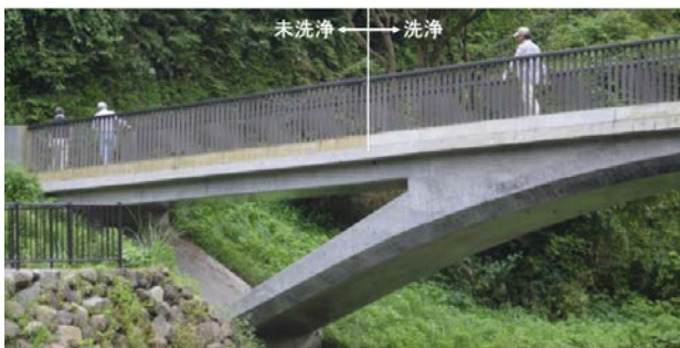
写真-11 滝側北の表面性状 (左:未洗浄 右:洗浄)
