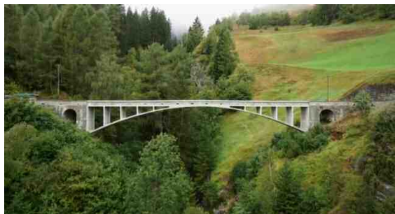
写真-3 Valtschielbach Bridge 1925 (Robert Maillart). マイヤールは、同系の Flienglibach Bridge(1923)でアーチリブ 25 cm という補剛アーチ構造に成功。
