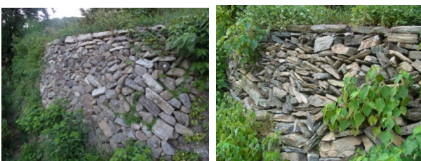
図-5 石積みの修復箇所（石積み学校以外）
