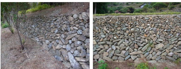
図-4 石積みの修復箇所 左：⑧ 右：④（石積み学校）
