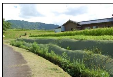
写真-4 除草シートをボタに被せているため、雑草が除草シートを持ち上げ目立つ印象を与えている不統一なボタ
