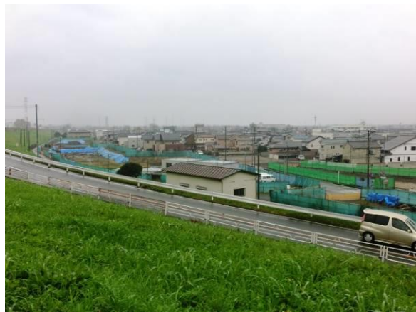
図-12 堤防に沿って用地買収が進む旧栗橋宿中心部(久喜市栗橋北2丁目)：2015年11月筆者撮影
