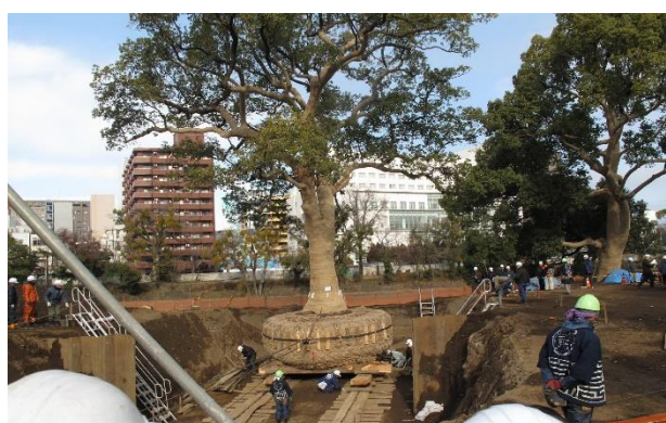
図8 立曳き工事の様子
