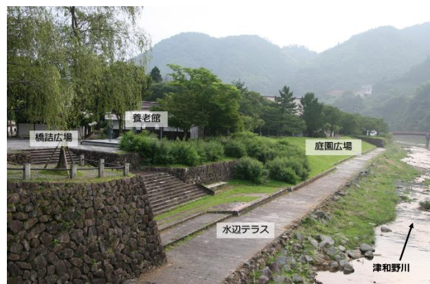
写真-1 津和野大橋下流左岸（津和野大橋から撮影）
