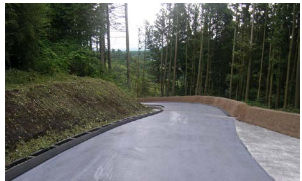
写真-11 完成写真(左:切土法面と排水,中央:舗装は半たわみ性舗装グレー,右:土堰堤)
