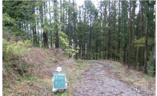
写真-10 仮設の工事用道路として使用した現況
