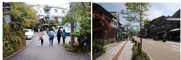
写真-7 「パターン6：歩行者優先の街路空間」 左：幅員狭く自動車の通行が困難で歩行者優先(黒川温泉) 右：歩車分離も、少ない自動車交通、最低限の車道幅(加賀山中温泉)
