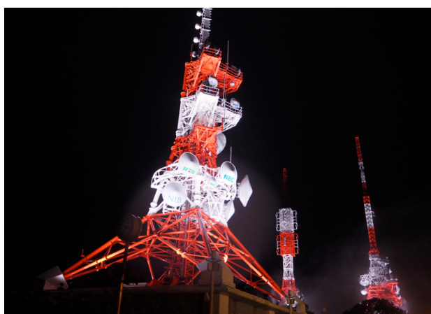
写真-4 稲佐山電波塔ライトアップの様子（平常時）
