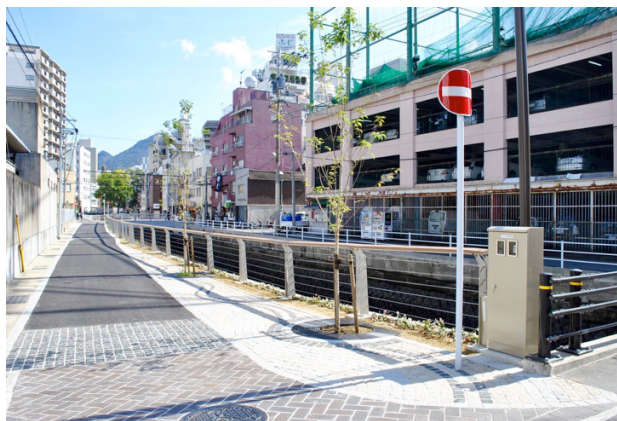
写真-3 岩原川プロムナードの完工した区間の様子
