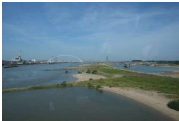
図2 建設中の分水路と De Oversteek 橋
