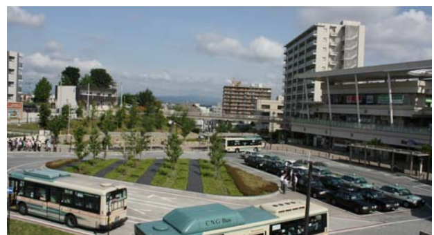
図-4 駅前広場デッキから広場を眺める。遠方に秩父連山を望む景色は、建築施設の分棟により実現している。
