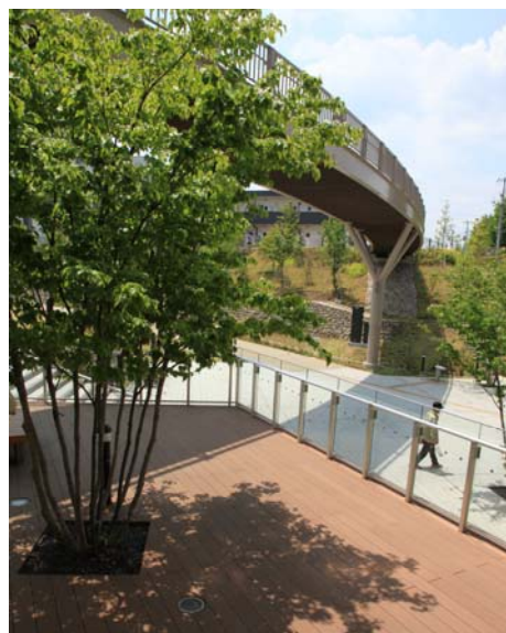
図-7 住宅棟ゲート付近から張り出した半公共のテラスの様子。普段は居住者の親子連れやお年寄りの憩いの場となっている。テラス下の階段踊り場に少し張り出し、互いに適切な広さがとれている。デッキ橋脚をテラスに取り込み、庇のような役割を兼ねている。
