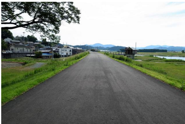
写真4 上流整備区間の堤防舗装(全面舗装)
