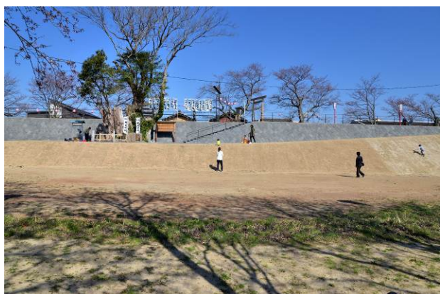
写真7 整備後の境楠周辺
