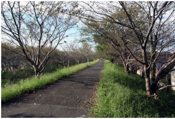
写真-2 整備前の堤防。天端幅約 5m。
