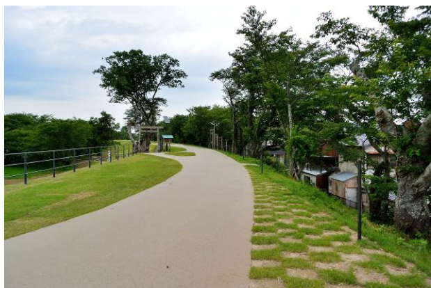
写真8 整備後の境楠周辺
