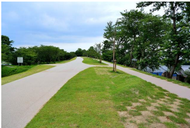
写真-3 整備後の堤防。半円形の盛土は月ノ輪
