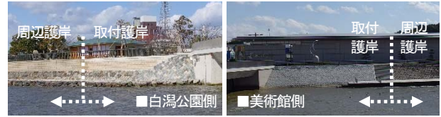
写真-5 既設護岸
