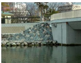
写真-11 左岸側水門取付護岸
