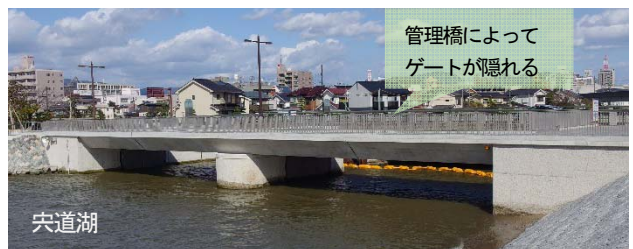
写真-3 宍道湖側（岸公園側）から見た際の天神川水門
