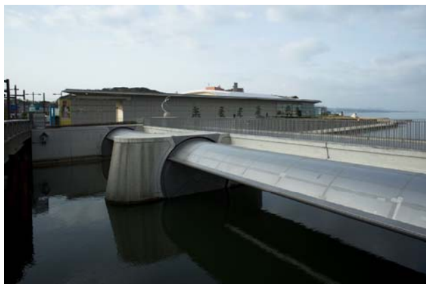
写真-12 完成写真
