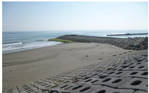
写真-9 突堤基部に養浜砂がついている様子(平成 27 年 3 月)
