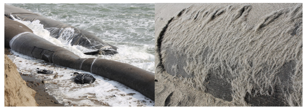
写真-17 サンドバック変状後
