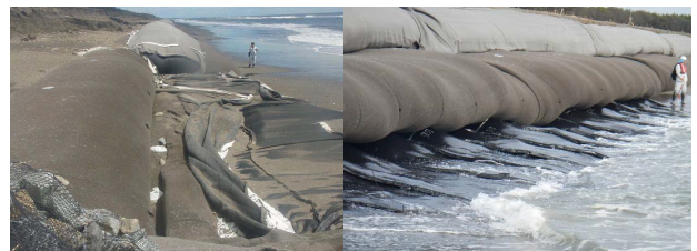
写真-15 流出した中詰り材
