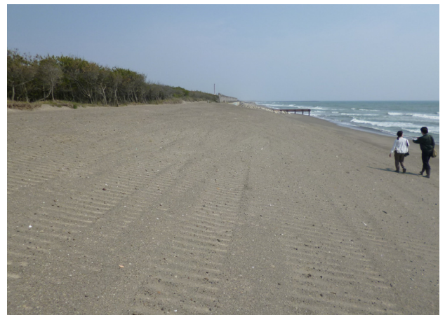
写真-6 サンドバックの埋設作業完了(平成 26 年 3 月)
