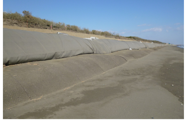
写真-5 サンドバック設置後(平成 26 年 1 月)
