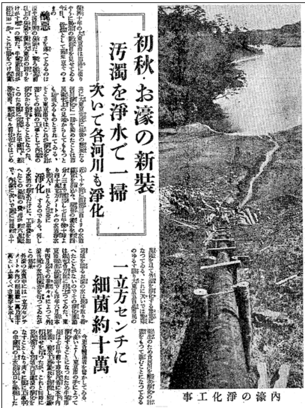
図4 浄水の直接引き込みの様子 (朝日新聞 1933. 9. 8)
