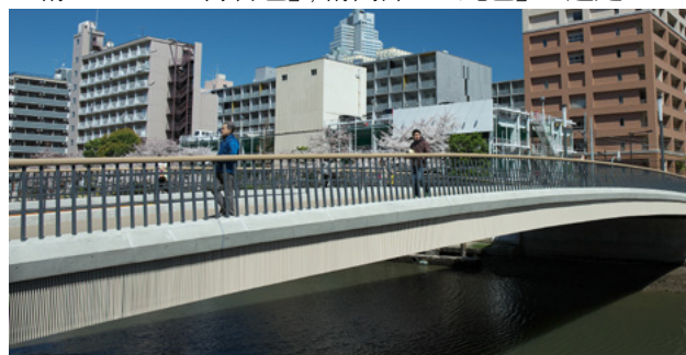
写真2 橋梁側面（日中）
