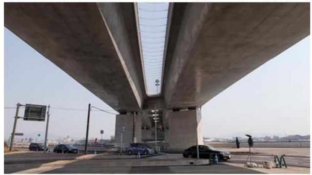
写真-3 P5付近. 西部高架に向かって上下線の桁を分離。
