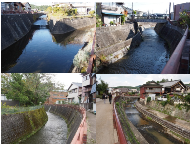
図-1 明智川の位置と現状 国土地理院地図に加筆 写真：左上から時計まわりに a, b, c, d が施工区間
