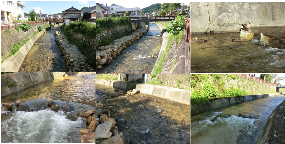
図-12 竣工後3ヶ月の様子 上段 左：本石橋から下流 中：下流から本石橋を 右：鴨の親子 下段 左：ダイナミックな落差工4 中：新規落差工下の淵が埋まっている 右：設計変更で埋められた落差工1
