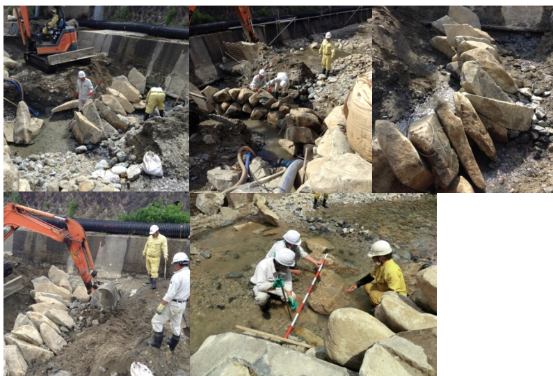
図-9 落差工の施工状況
