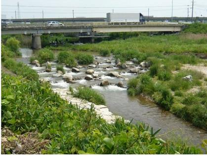
写真-4.1 籠川1基目の魚道(庭園の石工による施工)
