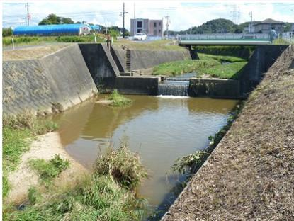
写真-2.2 既設落差工(H約1.5m)の状況(市木川)
