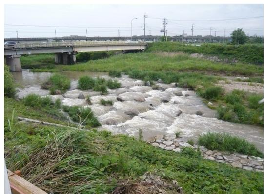
写真-5.1 洪水時の土砂の排出状況(籠川)
