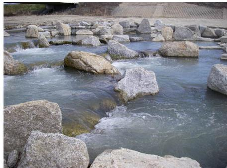
写真-3.5 越流部(ステップ)とプールの状況(籠川)
