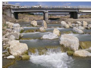
写真-3.4 施工後(H=0.3m/1段)
