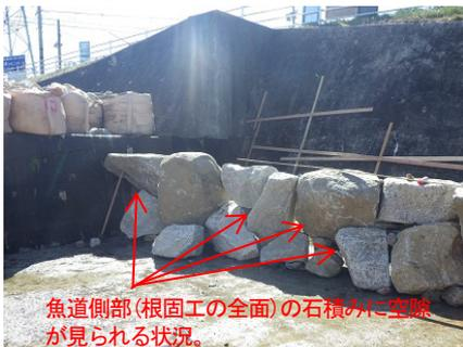
写真-4.3 施工指導の結果(土佐積み)
