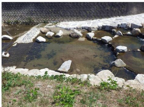
写真-5.2 土砂の侵食・堆積状況(市木川)
