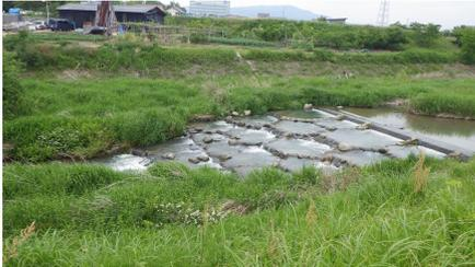
写真-4.2 籠川2~4基目の魚道(土木技術者による施工)(写真は3基目)
