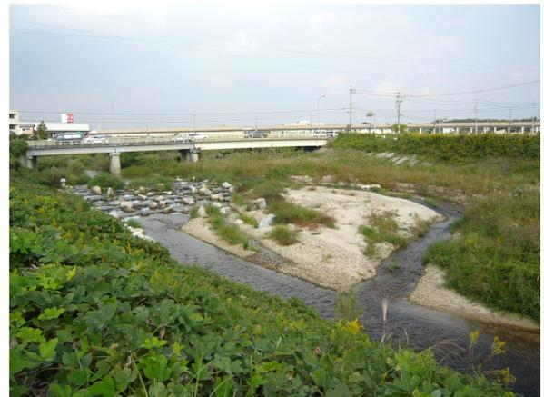
写真-3.1 魚道下流に発生した砂州(籠川1基目)
