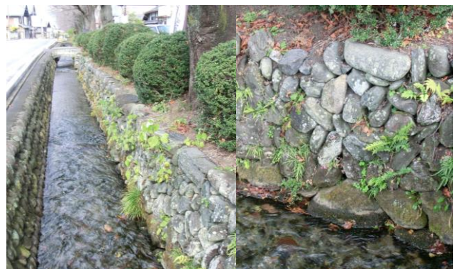
写真-1 大堰の石積み
