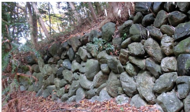
写真-3 小幡八幡宮境内の石積み
