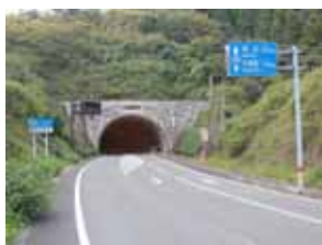
写真-9 トンネル入口
