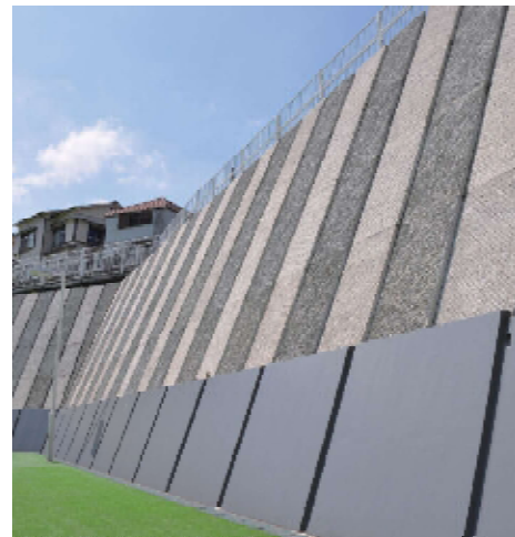
写真-1 ストライプウォール施工例
