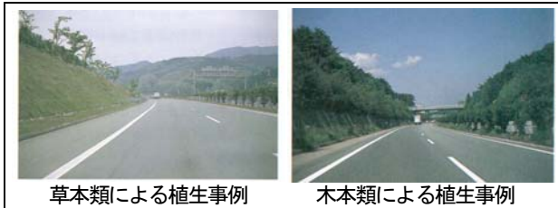
図-2 切土法面の緑化の事例
