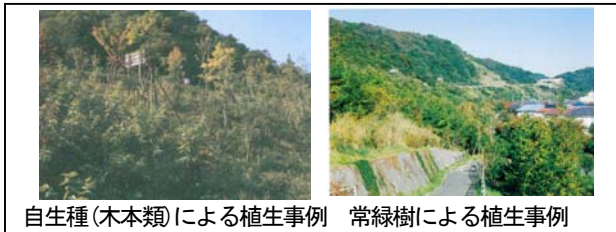
図-3 盛土法面の緑化の事例
