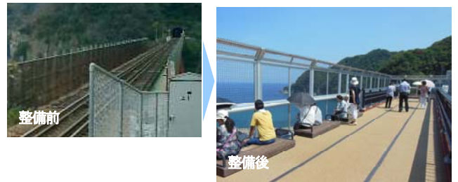
写真-1,2 余部鉄橋展望施設空の駅 整備前後写真
