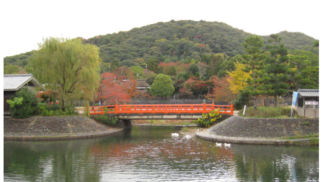
写真-2 現況橋梁写真（平成23年9月撮影）
