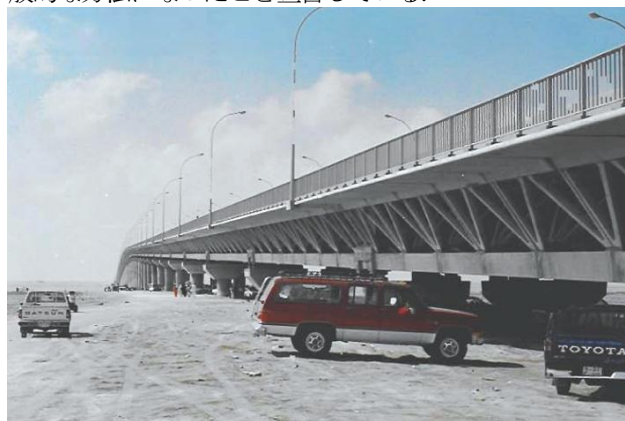
写真—2 クェートのBubiyan Bridge (1983年)
