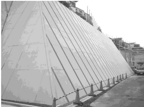
写真 - 8 施工直後の擁壁（⑫区間）
