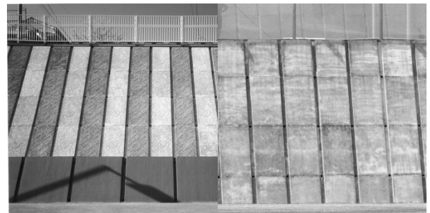
写真-3 擁壁全体の表情の違い
