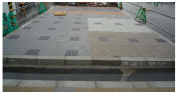
写真-2 舗装仕様確定のためのモックアップ
