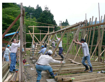
図-3 傍示地区における組み立ての作業風景
