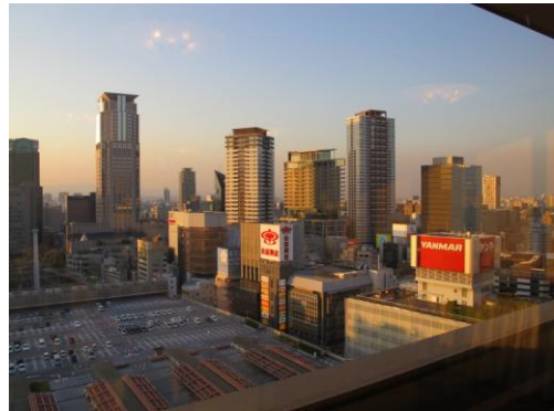
図-1 都市全体の林立したランドマーク(大阪市北区)
