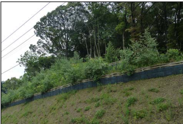
図-16 法面緑化の状況（付け替え道路部，2011/6/2）
