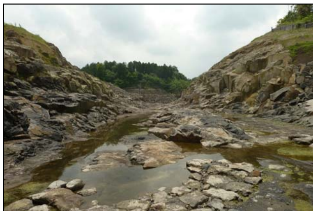
図-20 完成した河床の様子 (2011/6/2)
