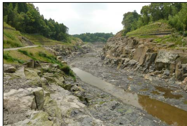
図-22 完成した曾木の滝分水路 (2011/6/2)
