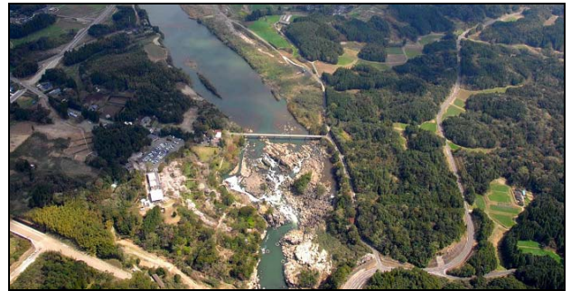
図-1 整備前の曾木の滝周辺（国土交通省提供）
