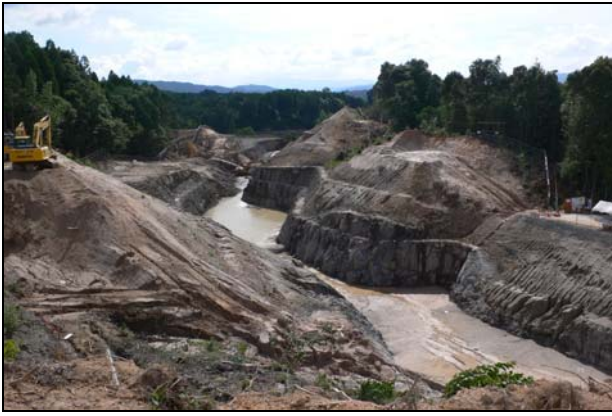
図-14 1次掘削後の状況（2009/7/7）
